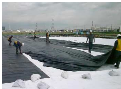
大気圧シート敷設
