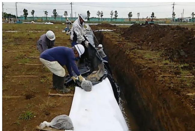
端部シート敷設
