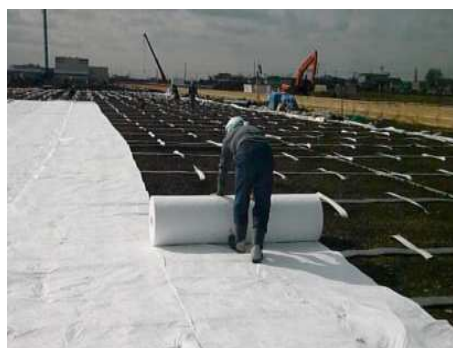
保護シート敷設
