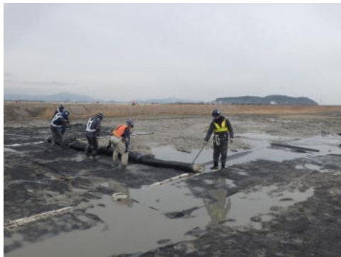
土木シート敷設
