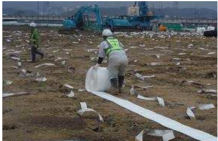
水平ドレーン布設
