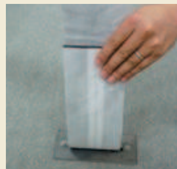
アンカープレート取付
