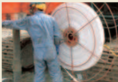
ドレーン材取付
